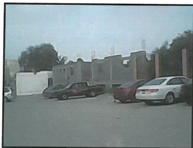
مبنى إداري قيد التنفيذ
