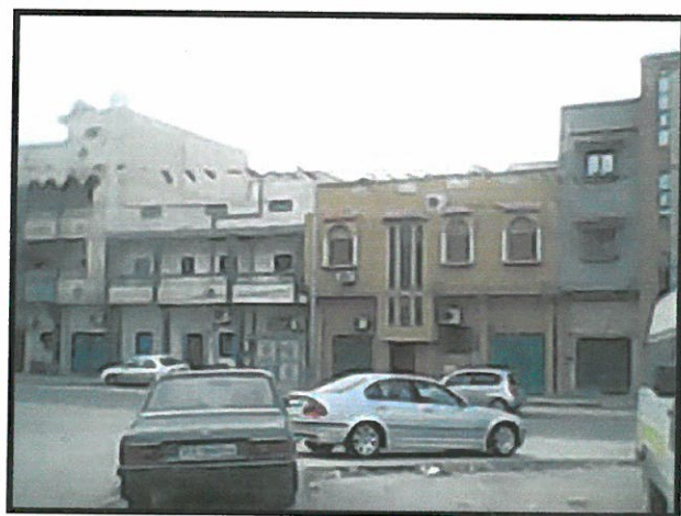
مساكن بعدة طوابق
