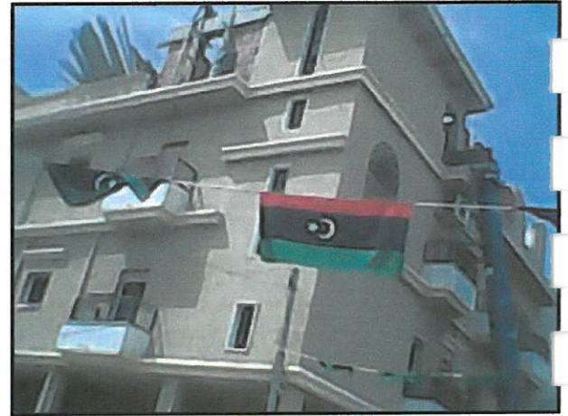
مبنى حديث الطراز (فيلا)
