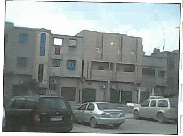
مساكن بعدة طوابق
