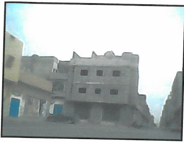
مبنى قيد الإنشاء
